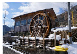
水車のかで発電する小水力発電
